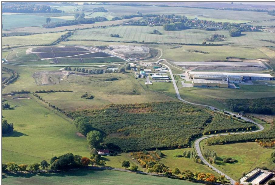
Abbildung 8: Luftbild der Abfallentsorgungsanlage
