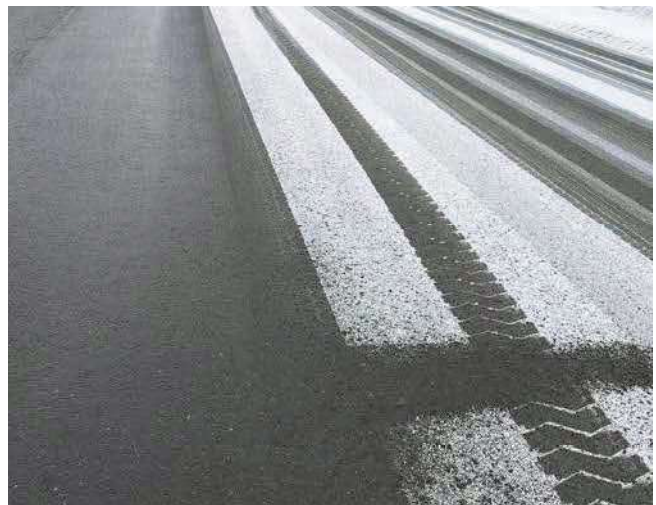
Vorteil Salzsole: gezielte Salzsoleaufbringung auf der Straße, Salzsole haftet sofort, kann nicht verweht werden
