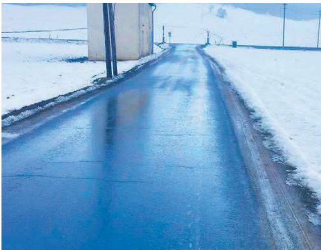
Vorteil Salzsole: gezielte Salzsoleaufbringung auf der Straße, Salzsole haftet sofort, kann nicht verweht werden
